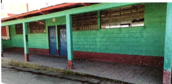
Foto 3: SUSTITUCIÓN DE VIDRIOS DE VENTANAS DE LAS AULAS
