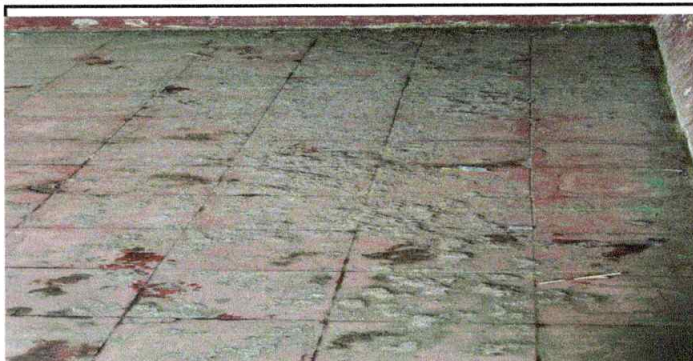
Foto 2: SUSTITUCIÓN DE PISO DE GRANITO
