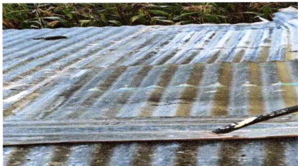
Foto1: SUUSTITUCIÓN DE LÁMINA POR LÁMINA TROQUELADA ALUZINC
